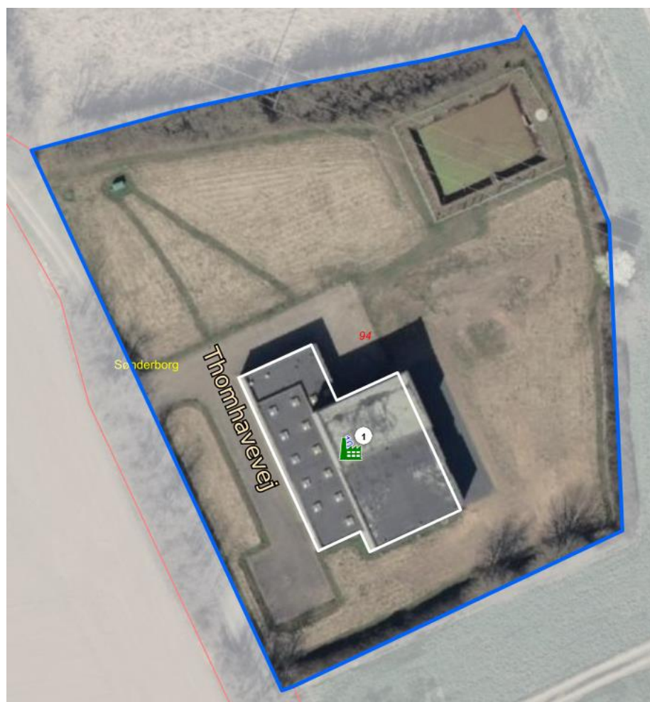
Figur 4.7: Oversigt over Mjang Dam Vandværk.
