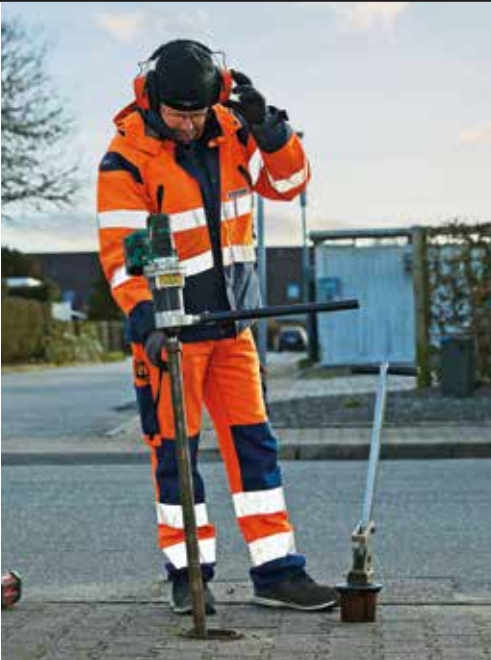
Drikkevandselskaberne "lytter på vandrørerne" for at finde utætheder. Foto: EWII
